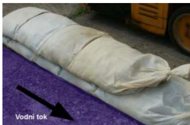
Jednořadé kladení pytlů podélně
