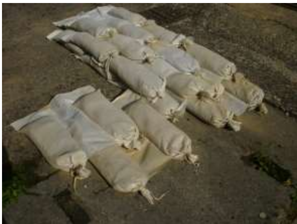
Umístění hráze z dvoukomorových pytlů
